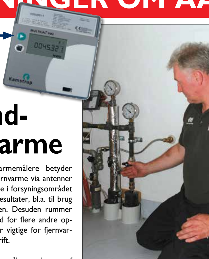
Ledningsmester Henrik Andersen, Aars Fjernvarme, viser, hvor returventilen skal lukkes, før der trykkes frem til markeringen l/h på den nye fjernvarmemålers display.
