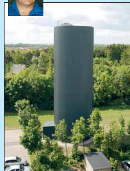
Akkumulerings-tanken kan rumme 800 m 3 vand.
