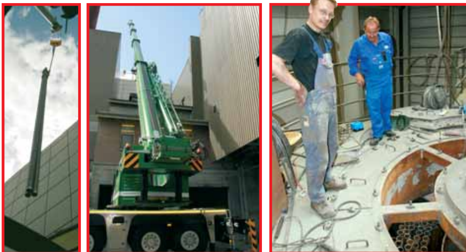
Via en kæmpekran hejses de nye rør op over toppen af ovnen, hvorfra de sænkes ned i ovnen. På billedet til højre ses Thomas Frost, Aalborg Industries, og Henning Mortensen fra Aars Fjernvarmeforsyning ved toppen af ovnen, hvor de installerede rør skimtes.
