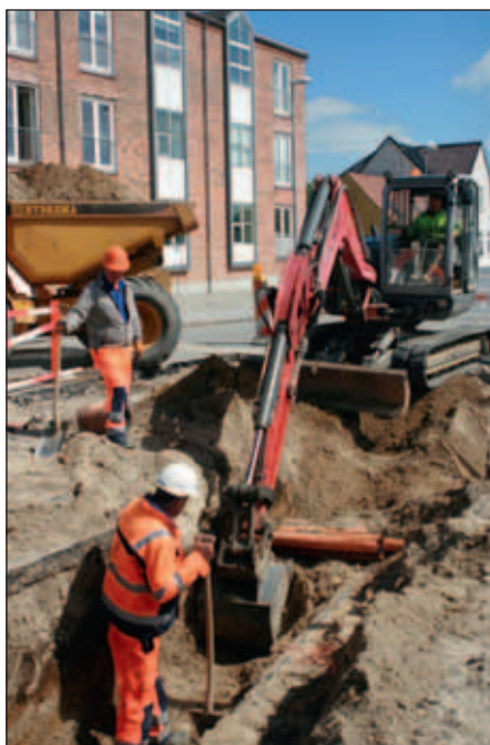
Gunnar Nielsen AIS foretager gravearbejde i forbindelse med udskiftningen af fjernvarmerør ved Aars Rutebilstation.
