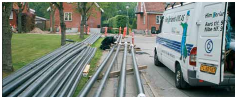
Solbakken i Aars forsynes med nye fjernvarmerør.
