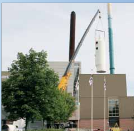
Kondenseringstanken løftes ved hjælp af en kæmpekran op til toppen af ovnhallen. Foto: Brian Støttrup
