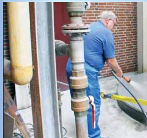
Værkmester Søren Sørensen, Aars Fjernvarmeforsyning ind på sit fundament.
