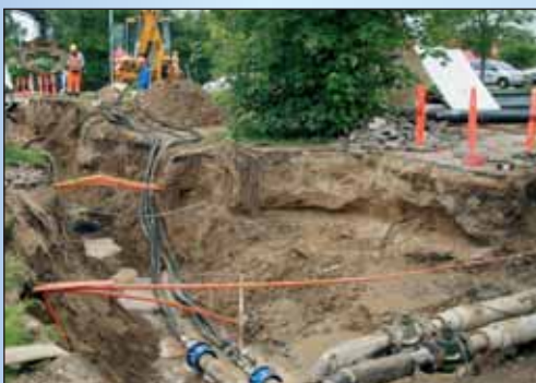
Aars Fjernvarmeforsyning udskifter gamle fjernvarmerør ved Gl. Tingvej i Aars.
